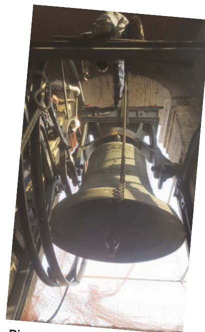
Riposizionamento della seconda campana.
