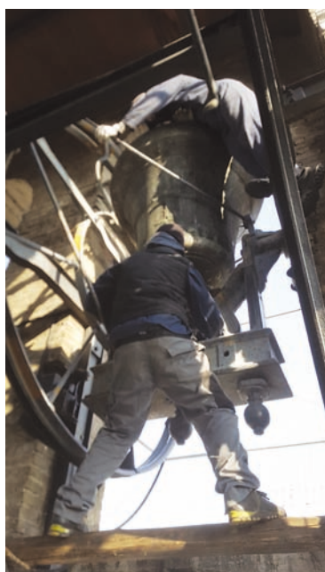
Riposizionamento della quinta campana. Il pericoloso lavoro di restauro.
