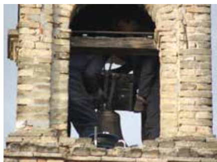
Installazione campana Ravere
